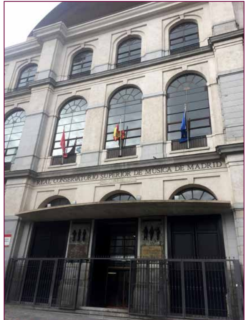
Fachada del antiguo Hospital Clínico de san Carlos.
