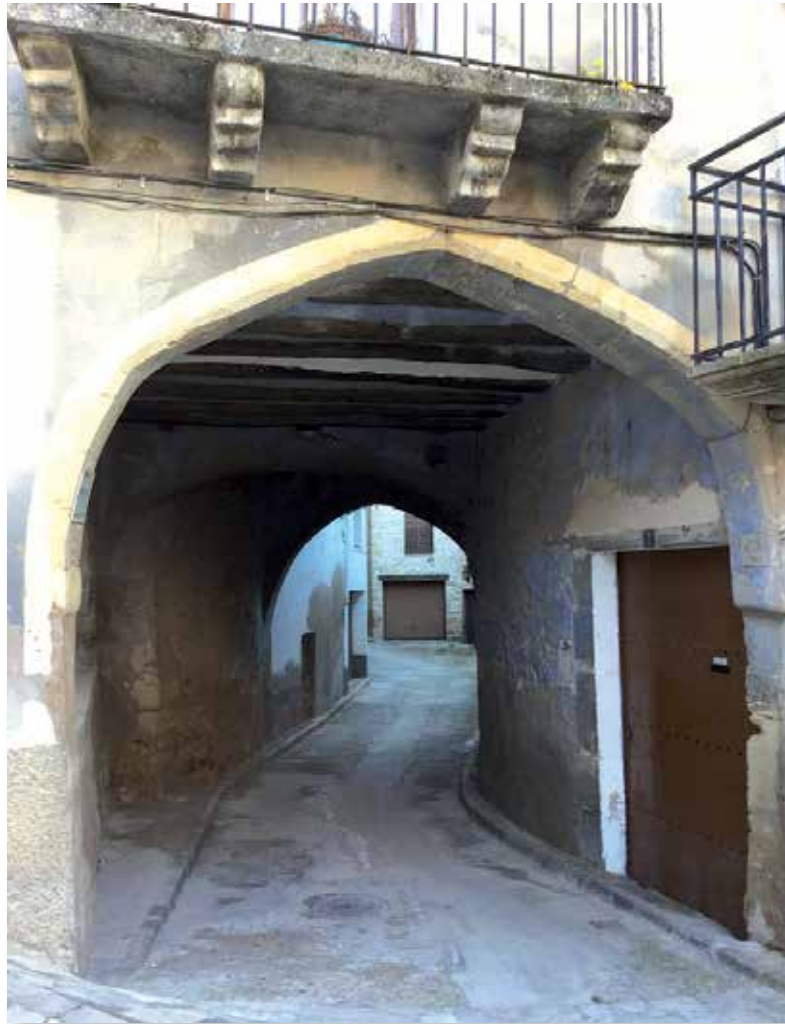
Calle empedrada de Monroyo.
